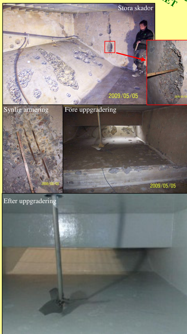
På bilderna syns den stora skillnaden före respektive efter uppgraderingen av betongen.
