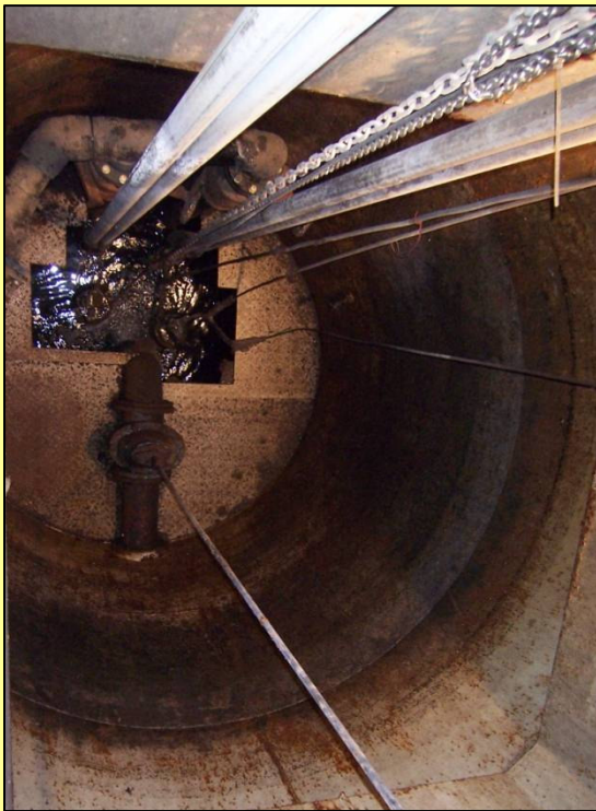
Bilden visar en av pumpsumpan före uppgradering.
