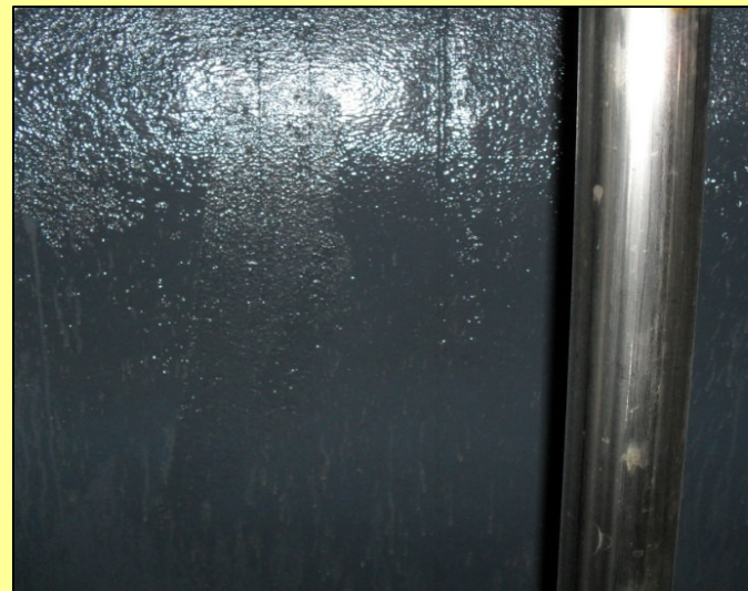
En närbild på ytan av pumpsumpan efter uppgradering med
