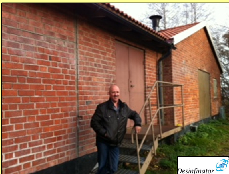
Jorma Seimilä framför en av de pumpstationer där den dåliga lukten av svavelväte försvunnit tack vare installation av luftreningsaggregat.
