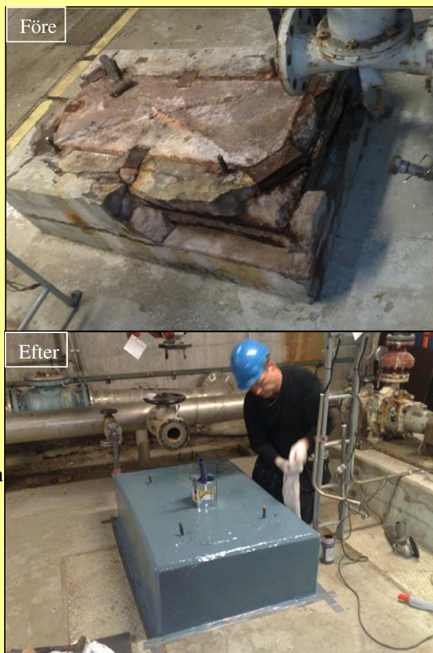
Bilderna visar vilka möjligheter vi har att återuppbygga slitna betongkonstruktioner med komposit, i detta fall ett fundament, till full styrka inom 5 arbetsdagar.
