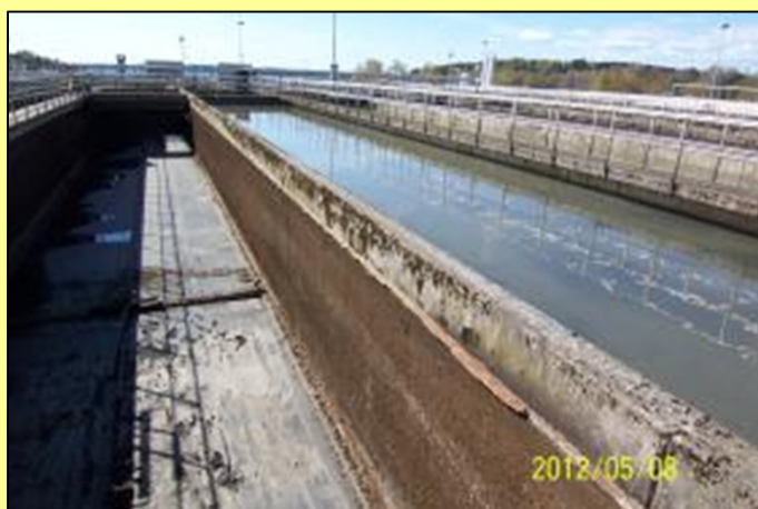
Den vänstra bassängen är tömd och där skall rengöring påbörjas.
