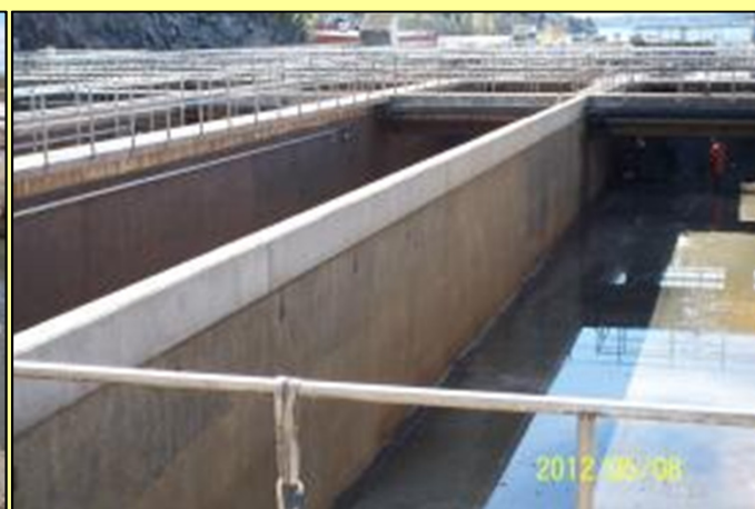
Den vänstra bassängen är klar att tas i drift och i den högra pågår rengöring och sedan vidtar beläggning.
