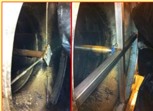
Till vänster ursprunglig konstruktion av fläkt-tillverkaren och till höger Spångs stabilare konstruktion för infästning av det inre lagret.
