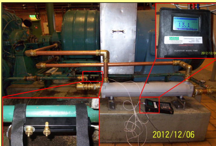
Mätning av kylflöden i 42 mm kopparrör vid Fortums anläggning i Hässelby.
