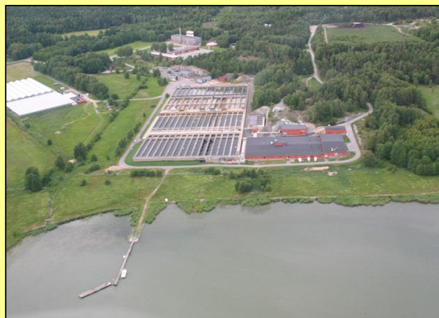
Syvab (Himmerfjärdsverket) sett från ovan.
