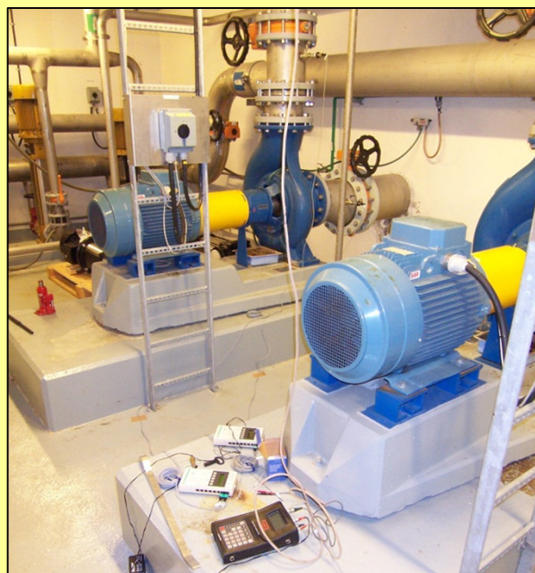
Mätning av system bl a flöde, tryck, eleffekt mm.
