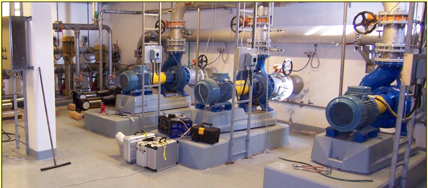
En bild från tidigare prestandamätningar av pumpar där bl a flöde, tryck och eleffekt loggas för beräkning av verkningsgrader.
