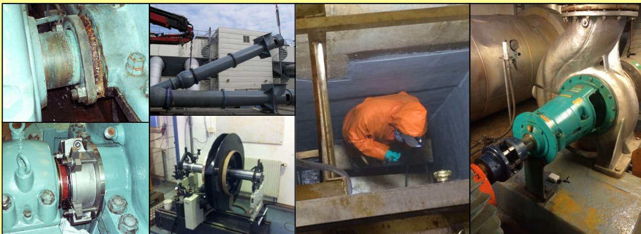
Bilder från olika arbeten; ombyggnad från boxpackning till delad tätning, återmontering, balansering, kompositbeläggning samt uppgradering av pump.
