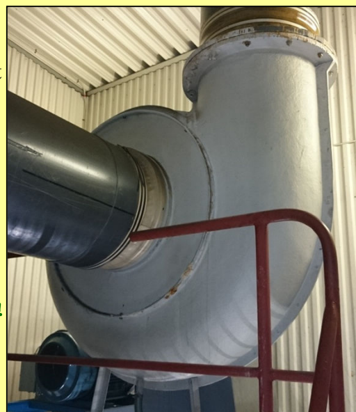
Fläkten vars snäcka och hjul är konstruerad i FRP, dvs glasfiberförstärkt plast.
