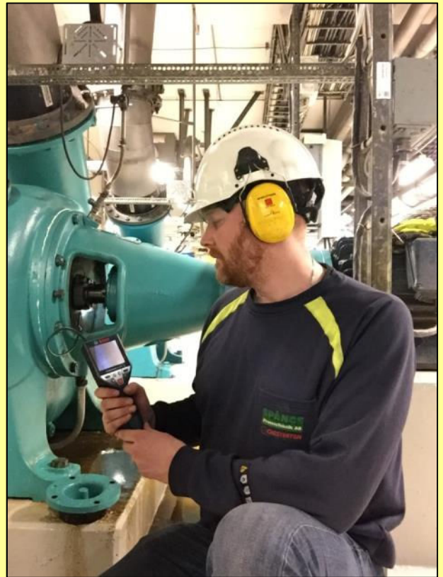
Nicklas genomför fiberoptisk inspektion av pump på Syvab, Himmerfjärdsverket.
