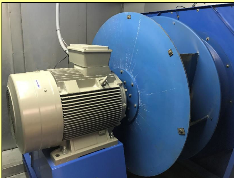
Direktdriven fläkt som balanserades i två plan (de båda gavlarna). Tre av balanseringsvikterna syns på fläktgaveln som vetter mot motorn.
